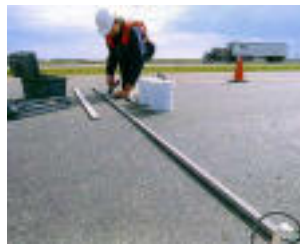
Abbildung 1.3: Piezo-Sensor: Ein koaxiales Kabel ist in eine Aluminium-Umhüllung gekleidet. Der ganze Sensor wird dann in die Fahrbahn eingebaut.
